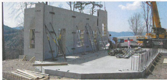
Wohnlich: Keller können vielfältig genutzt werden (oben). Dicht: der schwimmende Keller von Bürkle (Mitte). Vorgefertigt: Die Kapelle „St. Anna“ auf dem Dollenberg wurde mit Bürkle-Wandelementen erstellt.
